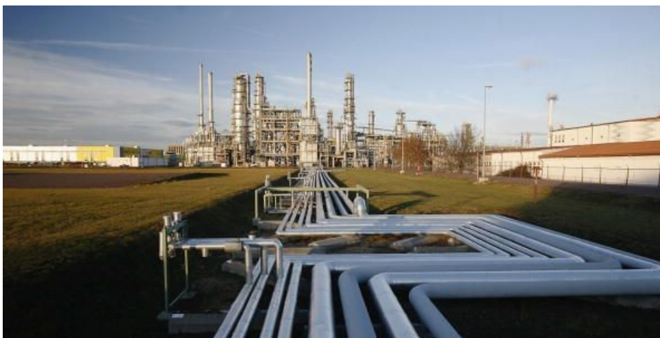
Fig. 2.3 : Pipelines de canalisation
