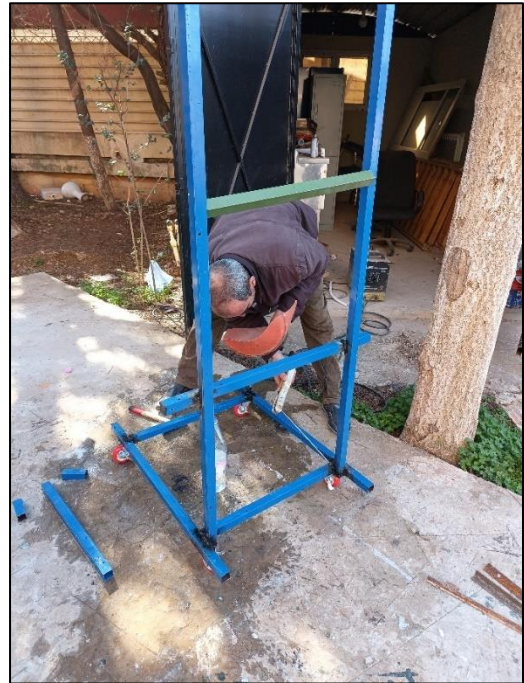
Figure III-11 Soudage des supports métalliques
