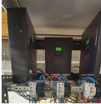
FIGURE 3.19 – Onduleurs solaires multifonctionnelle (3 triphasé ).
