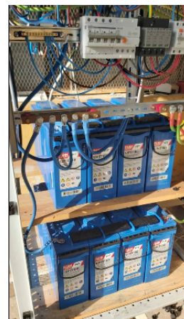
FIGURE 3.18 – Armoire électrique avant de mettre les batteries et Avec les batterie
