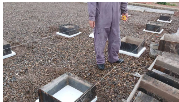
FIGURE 3.13 – alignement les semelles de béton
