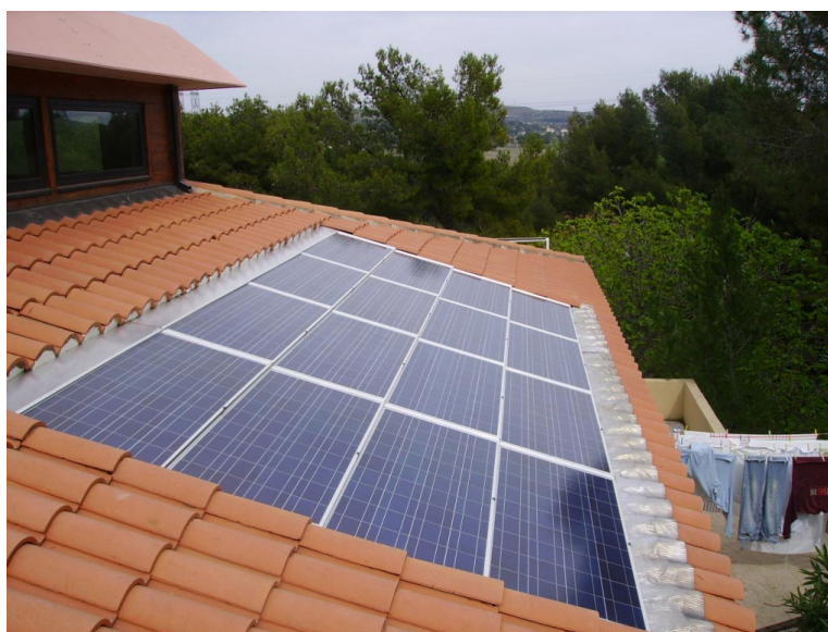
FIGURE 2.3 – Installations avec une intégration au bâti.
