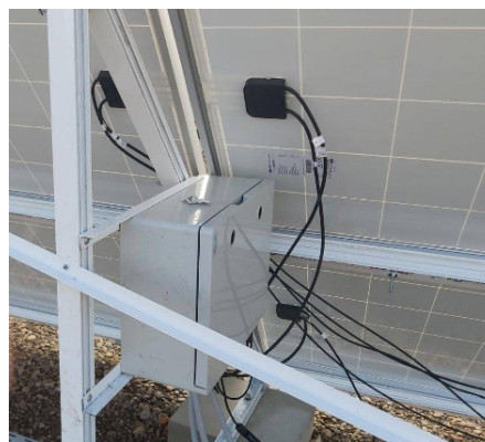
FIGURE 3.16 – Boîte de jonction (toiture).
