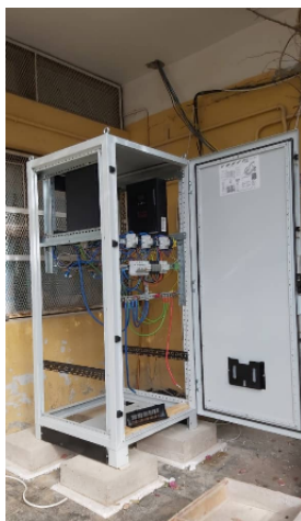
FIGURE 3.18 – Armoire électrique avant de mettre les batteries et Avec les batterie
