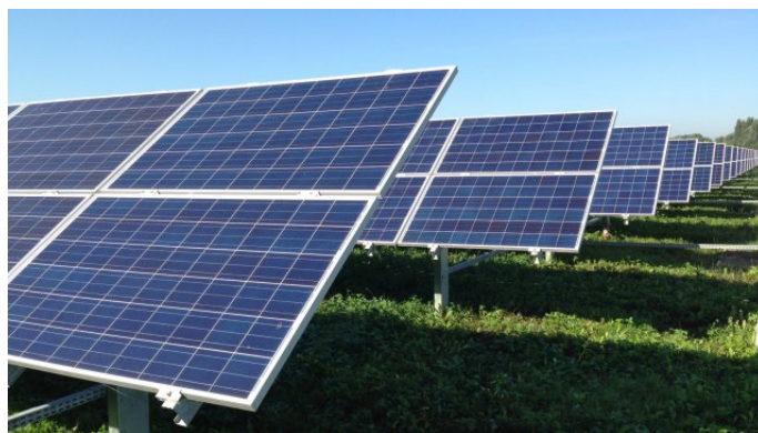
FIGURE 2.1 – Installations non intégrées.
