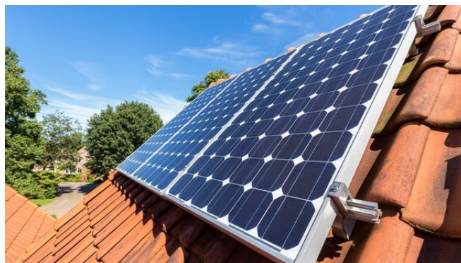
FIGURE 2.2 – Installations avec une intégration simplifiée au bâti.
