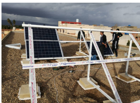
FIGURE 3.15 – Structure porteuse avec modules photovoltaïques.
