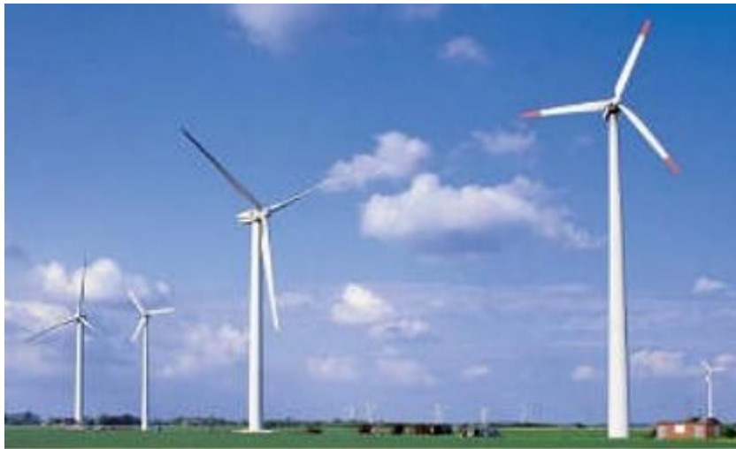
Figure (I.4) : Aérogénérateur à axe horizontal [17].
