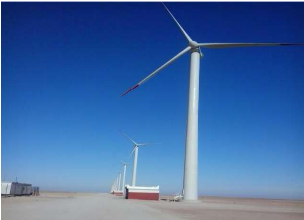
FigureI.1 - Ferme éolienne de Kaberten à Adrar
