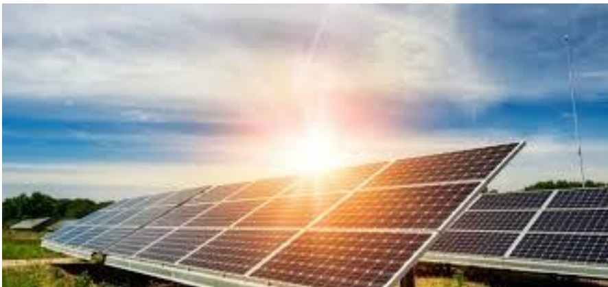
Fig.I.5 : Installation de l'énergie solaire.
