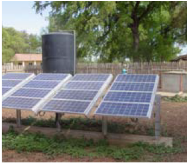
FIGURE 1.7 – Irrigation d'un jardin avec une pompe solaire [11]
