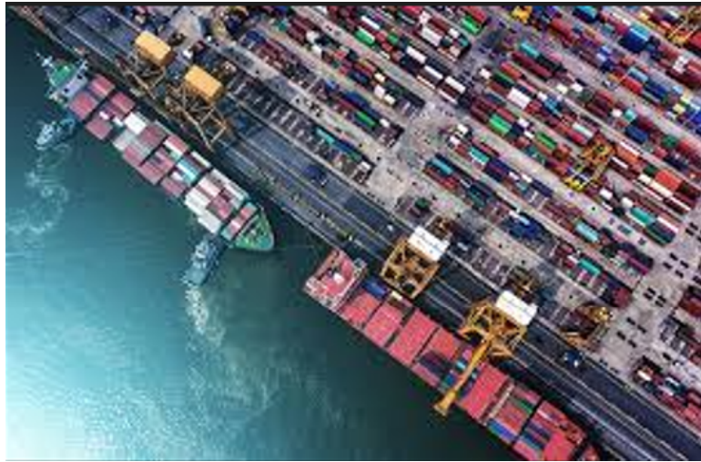
Figure I.7 Terminal à conteneurs [5].
