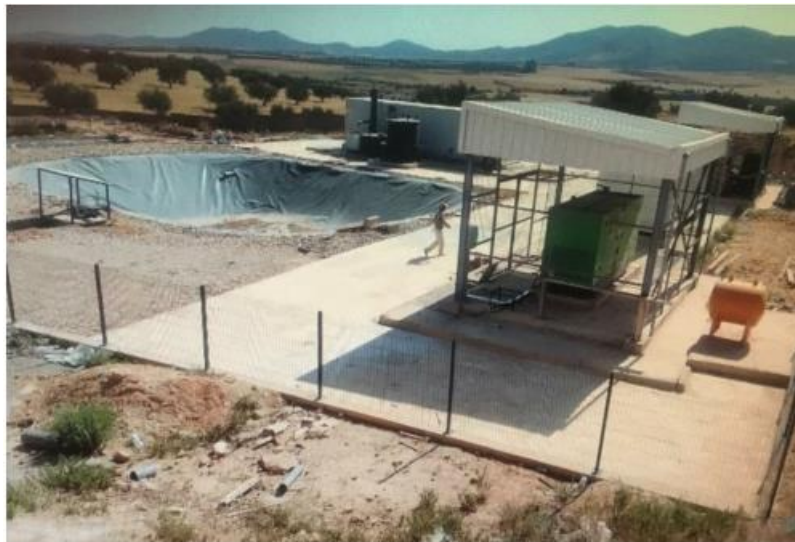
Figure I-3:Station de traitement de lixiviat [3]
