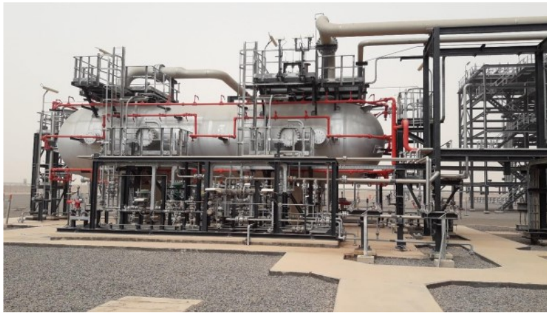
Figure 1.2: Slug-catcher "ballon de séparation".
