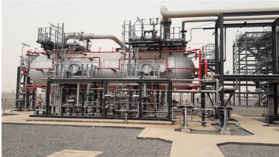
Figure 1.4: Slug-catcher "ballon de séparation".
