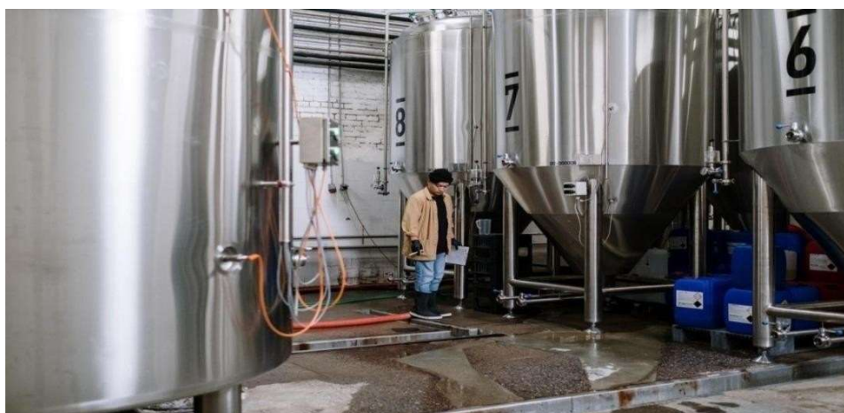
Figure 1-14 : des réservoirs en acier qui contient un liquide [18]
