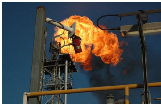
Figure II. 14 : Détecteur de flamme à imagerie visuelle et vue d'une détection dans un procédé
