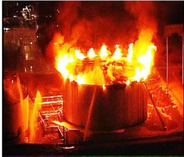
Figure 1.7 :Le Slopover « Feu de réservoir »
