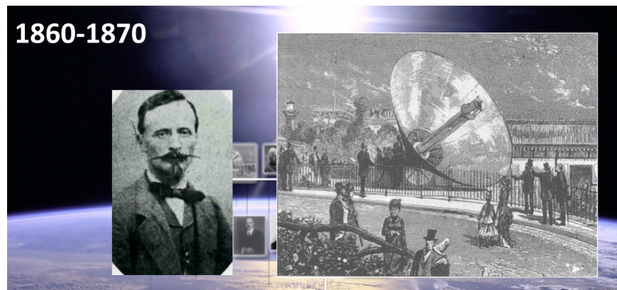
FIGURE 1.4 – Premier moteur solaire avec un réflecteur solaire inventé par le français Augustin Mouchot [4].
