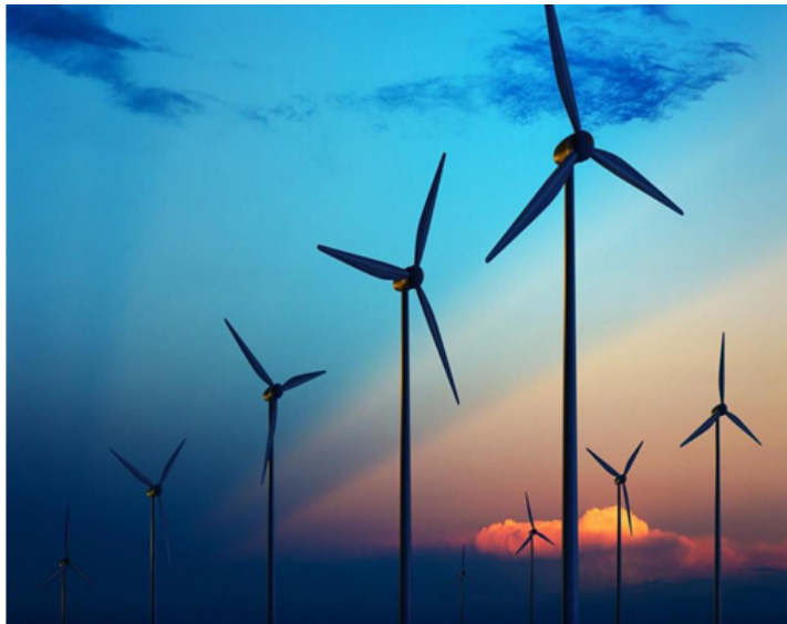
FIGURE 1.12 – Champ d'éoliennes à axe horizontal.
