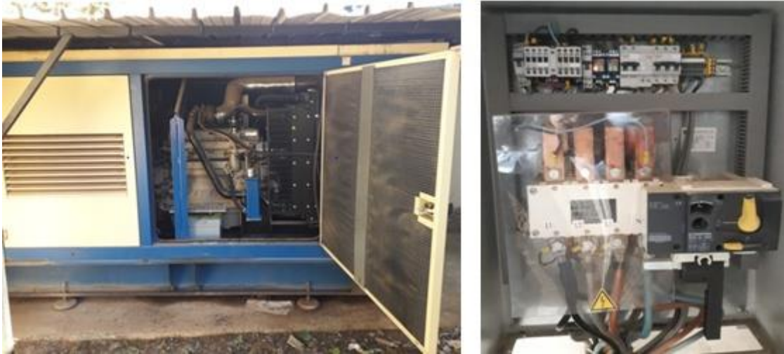
Figure IV-4 Groupe électrogène et armoire d'inverseur
