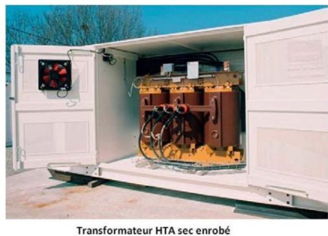
Figure I-14 Transformateur HTA/BT[6]
