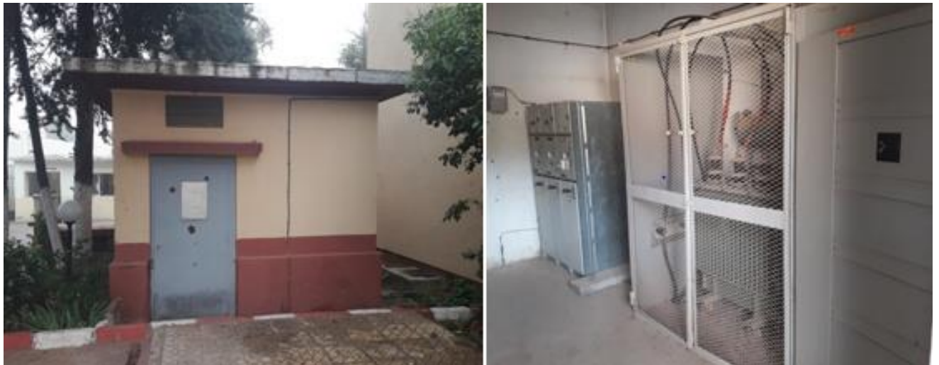
Figure IV-3 Poste maçonné HTA/BT N°7055
