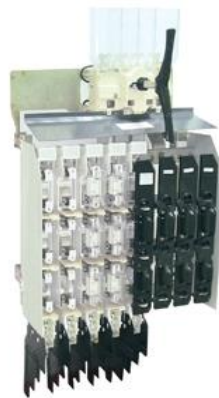
Figure II-1 Tableau électrique général basse tension[10]
