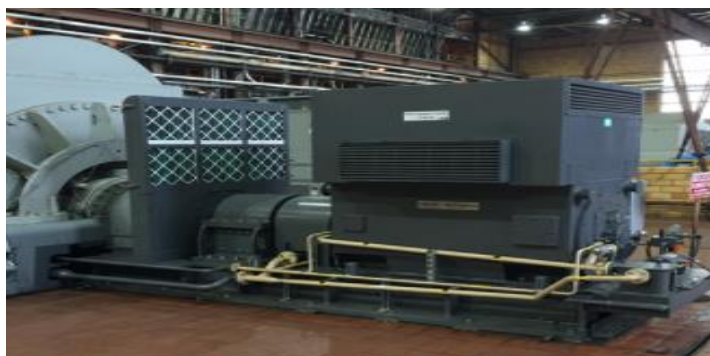
Figure III-3 Compensateur synchrone ABB
