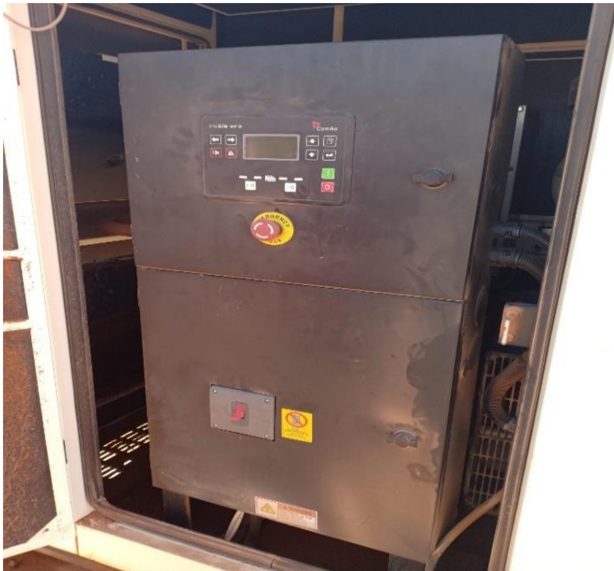
Figure 3. 10 : Automate du groupe de 160 KVA
