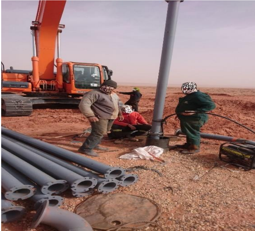
Figure 3. 15: premier forage du site Bnoud
