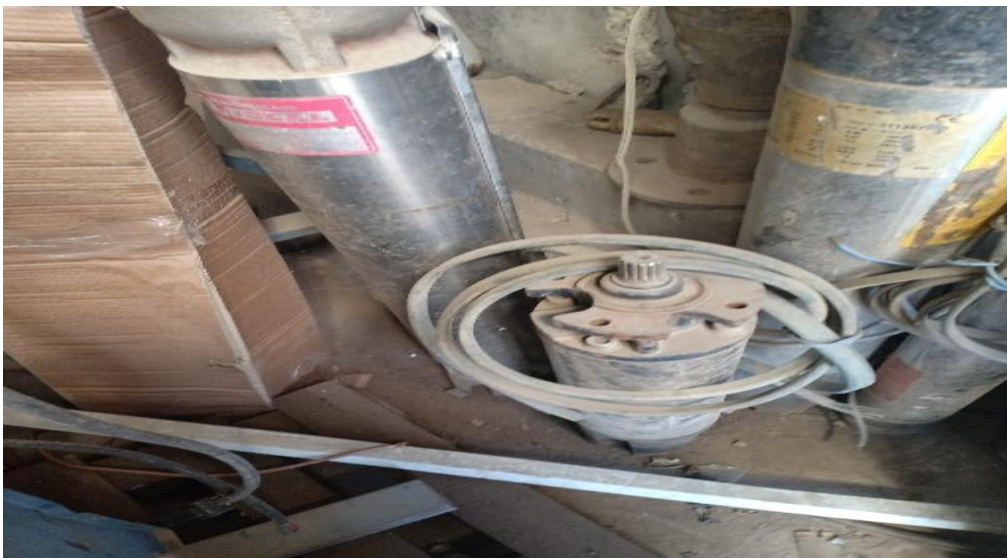
Figure 3. 17: Pompe de 70 Chevaux dans l'atelier de réparation, actuellement
