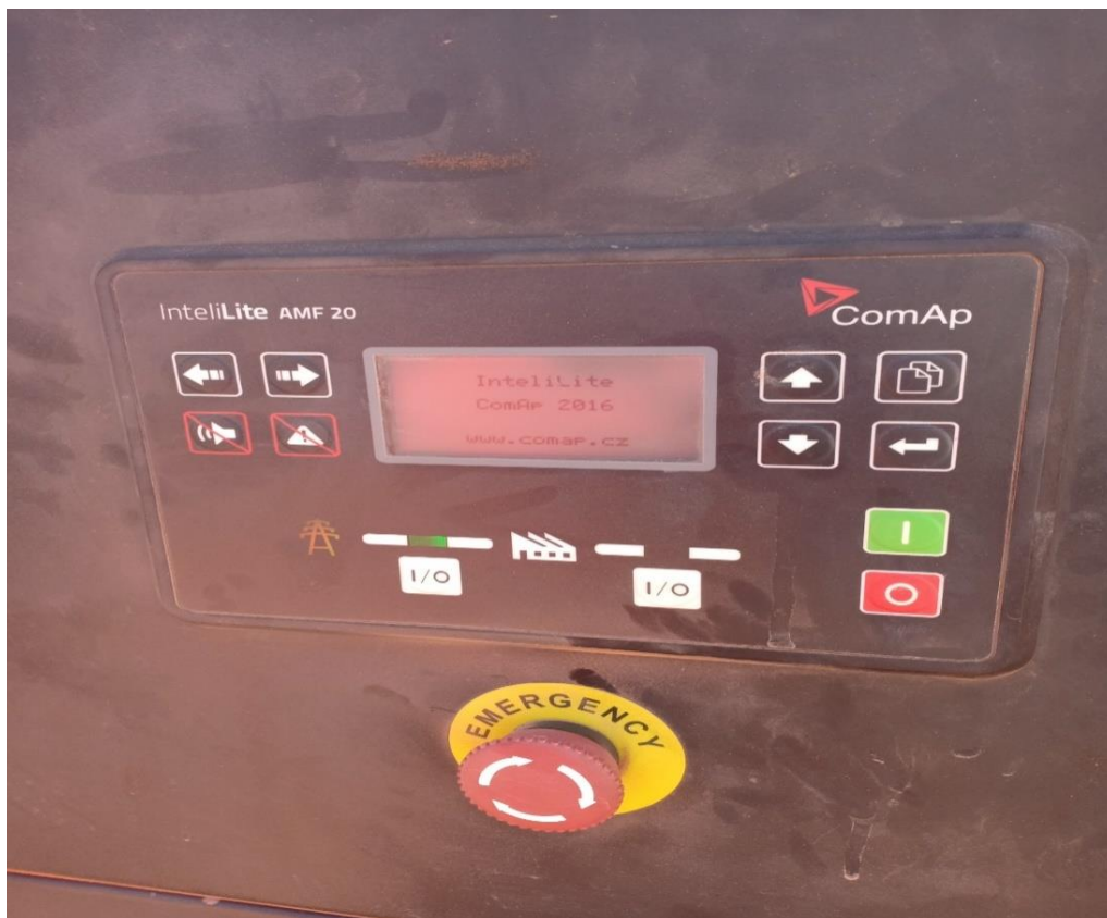
Figure 3. 12 : l'automate une fois alimenté
