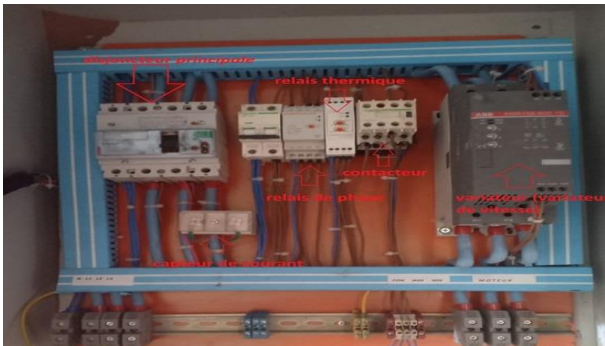
Figure 3. 19: armoire de la pompe 70 Chevaux actuellement en réparation
