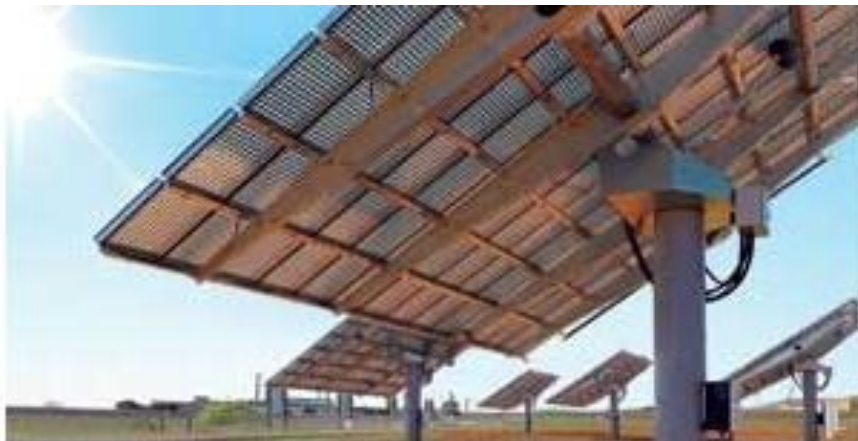
Figure II.3 : Installation avec traqueur solaire [15]
