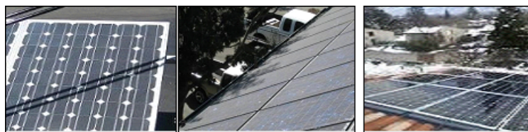
FIGURE 1.20 – Défaut d'ombrage partiel.
