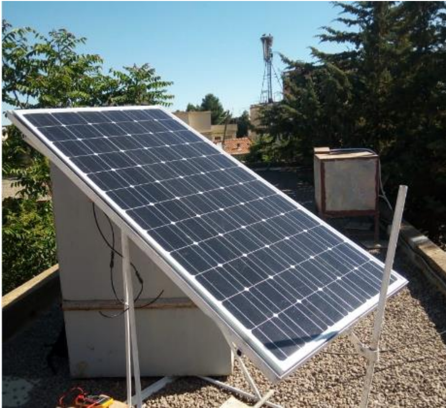
Figure III-13 L'installation du panneau solaire.
