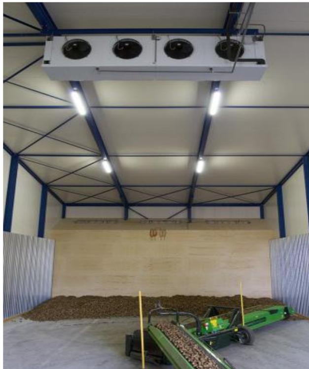
**Figure III-11** : Système de ventilation dans un entrepôt de stockage en vrac <sup>[59]</sup>.
