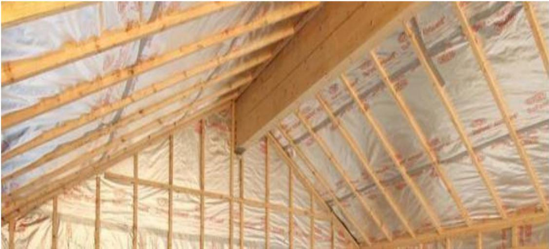
Figure III-9 : Une installation du pare-vapeur [55].
