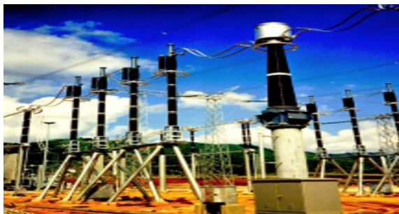
FIGURE 2.11: Disjoncteur
