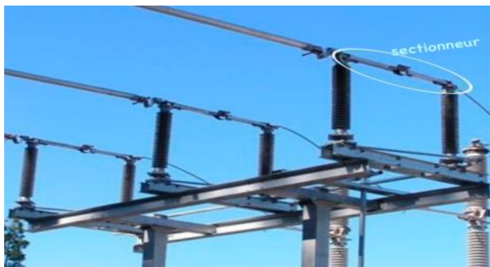
FIGURE 2.10: Sectionneur
