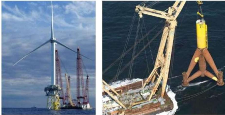
**Figure I.19: fondation tripode et Jacket. [27]**
