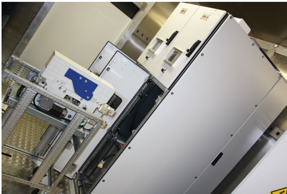
FIGURE 2.28: Disjoncteur ultra rapide.
