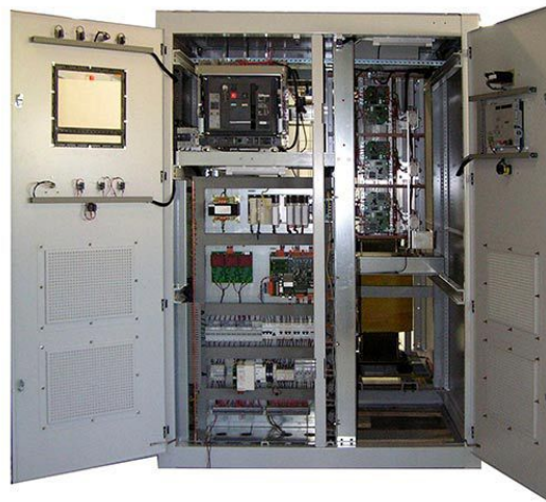
FIGURE 2.26: Groupe redresseur de courant en traction.
