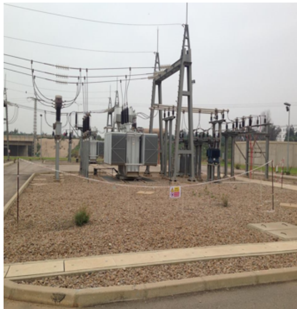
FIGURE 2.21: Transformateur 60/30 kV.
