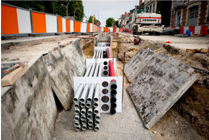
FIGURE 3.22: La pose de multitubulaire
