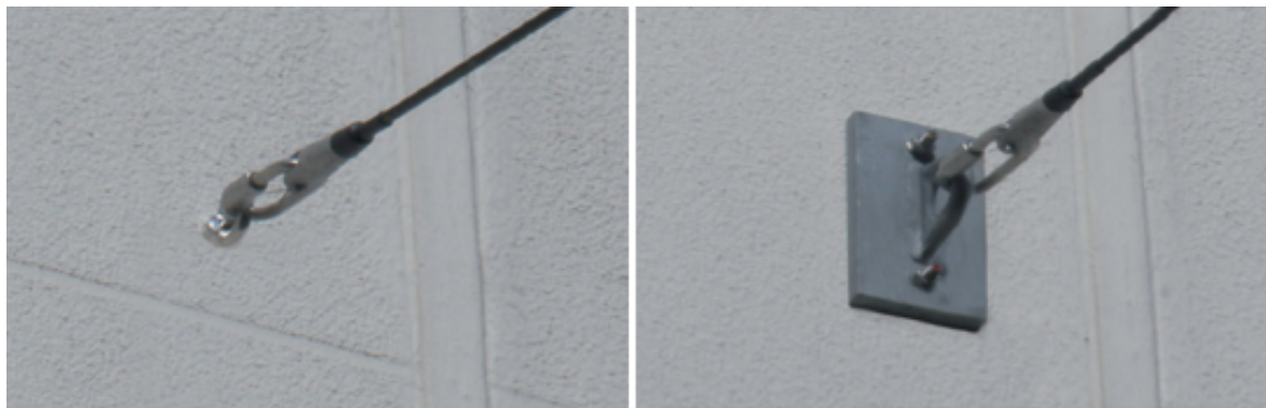
FIGURE 3.24: Ancrage simple et ancrage avec platine.
