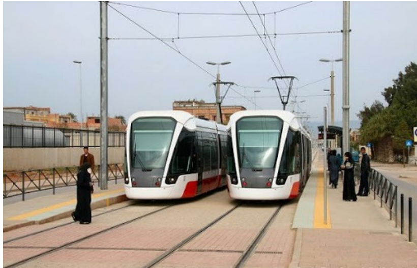
FIGURE 3.40: Insertion du poteau bilatéral.
