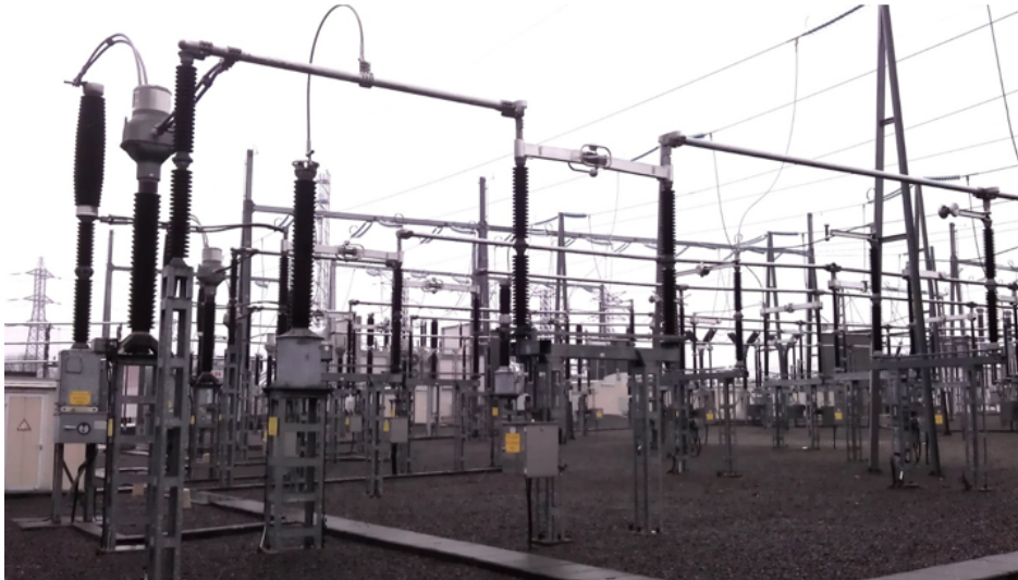
FIGURE 2.19: Jeux de barres de couplage.
