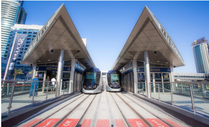
FIGURE 1.6: Alimentation par le sol à Dubaï
