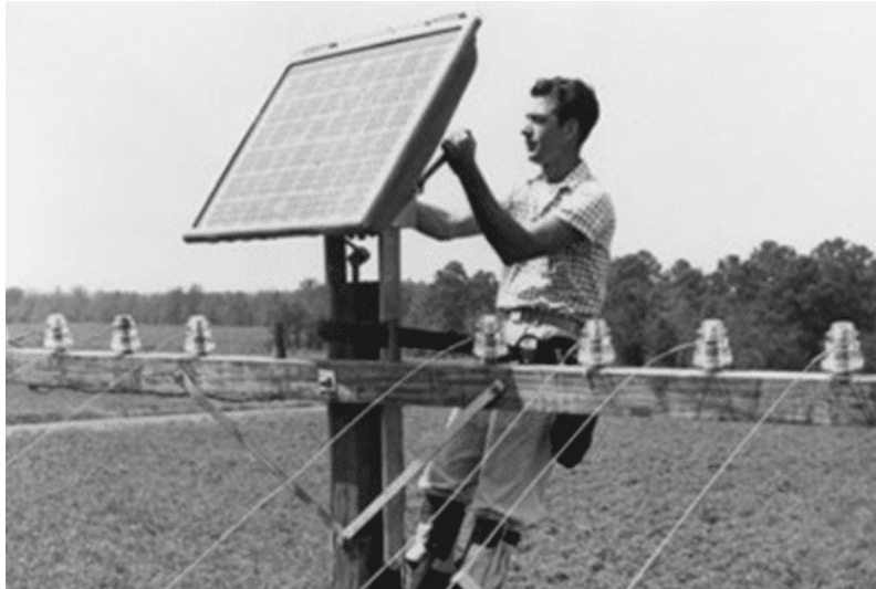
FIGURE 1.2 – Installation de la première cellule solaire
