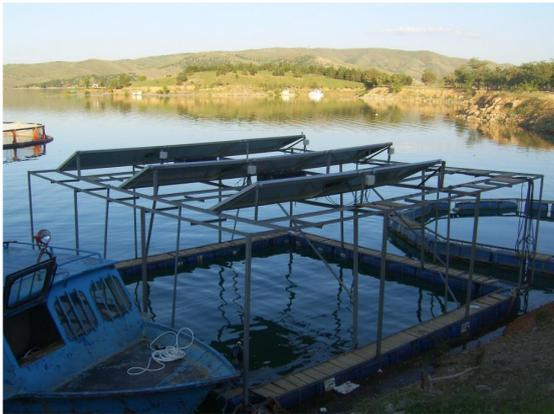
(a) Réseau photovoltaïque développé construit sur la cage à poissons
