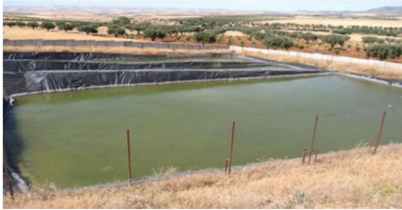
Figure 20: Les bassins de lixiviat[15]
