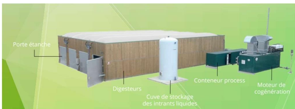
Figure 5: La méthanisation par voie sèche[4]
