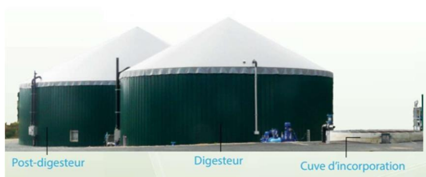
Figure 6: La méthanisation par voie humide [5]
