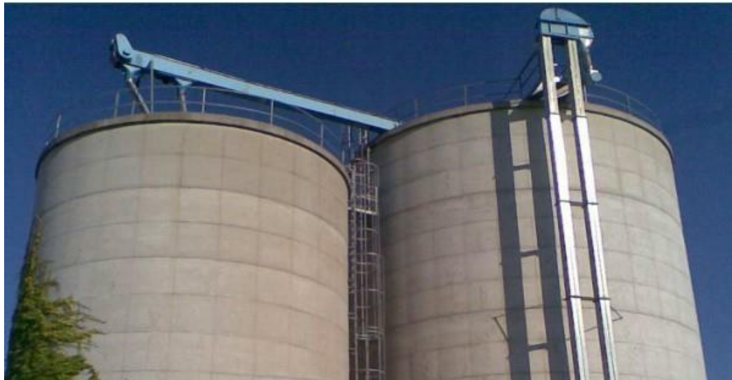
Figure 2.3: Silos en béton [7]
