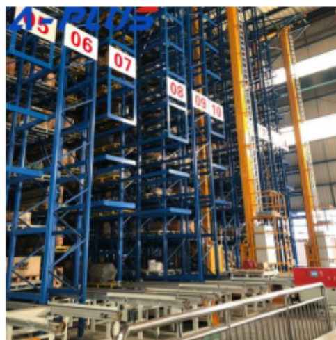
Figure 1.9: AS/RS à rack glissant
