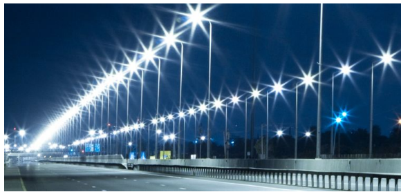
FIGURE 1.2: Éclairage public d'une route
