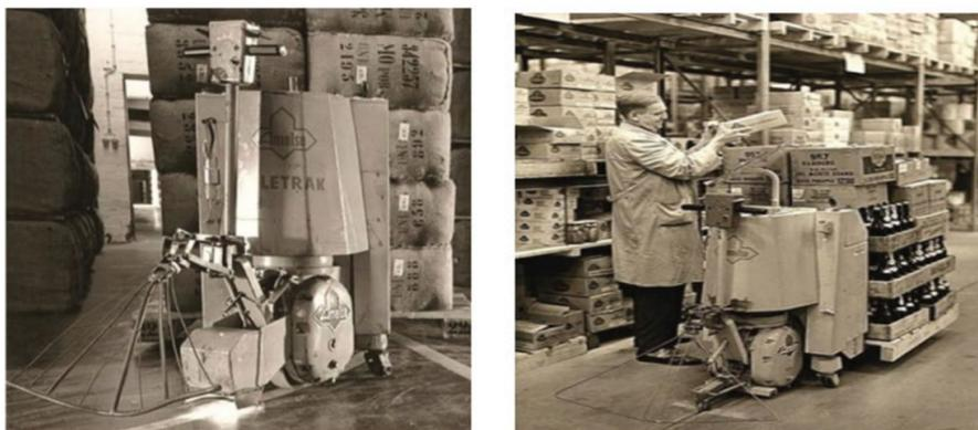
FIGURE 1.2: L'ancien AGV avec treillis métallique comme capteur de pare-chocs.
