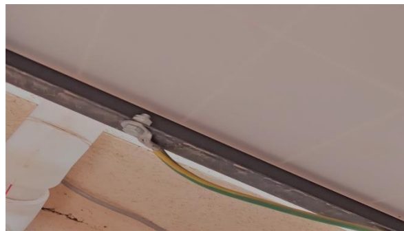
Figure 87 : L'installation de la prise de terre dans le châssis.
