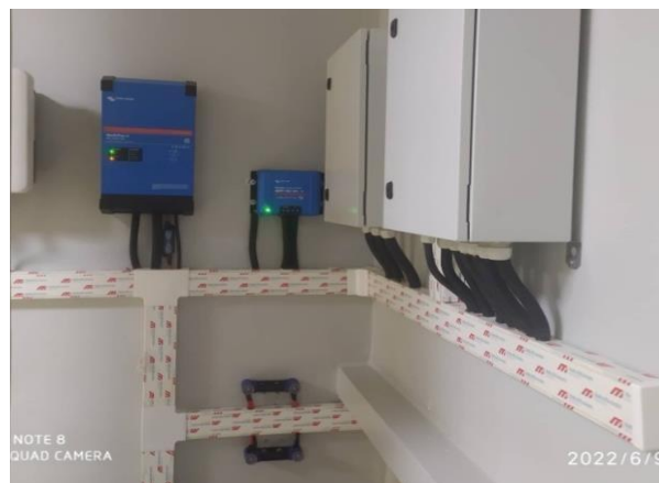
Figure 69 : Le montage Régulateur–convertisseur-le système de protection.
