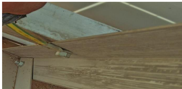
Figure 63 : Installation de la prise de terre dans le châssis.
