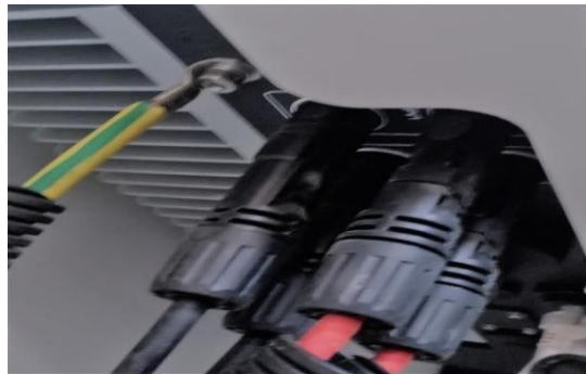
Figure 89 : La connexion avec l'onduleur.
