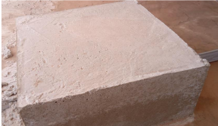
Figure 60 : La fondation en béton (50 * 50 * 20).
