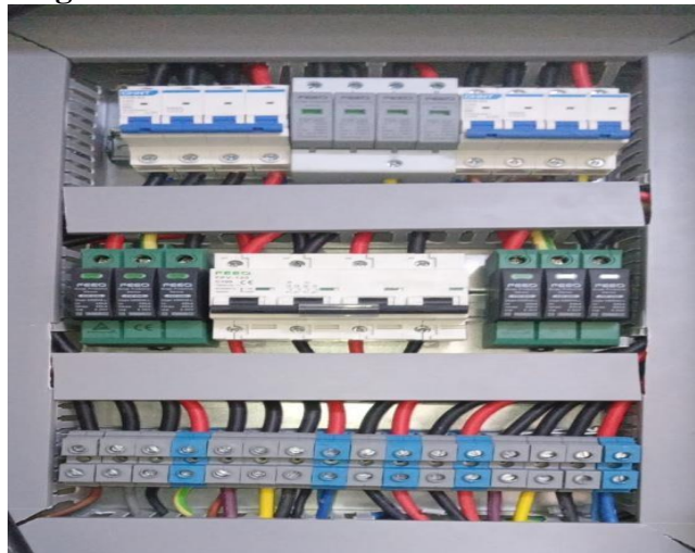
Figure 89 : La connexion avec l'onduleur.
