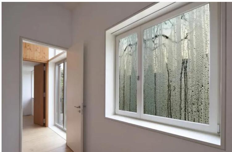
**Figure I-4 :** Exemple de condensation à l'intérieur du bâtiment. [8]
