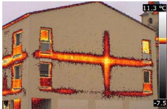
**Figure I-2 :** Exemple de pont thermique sur un bâtiment. [5]
