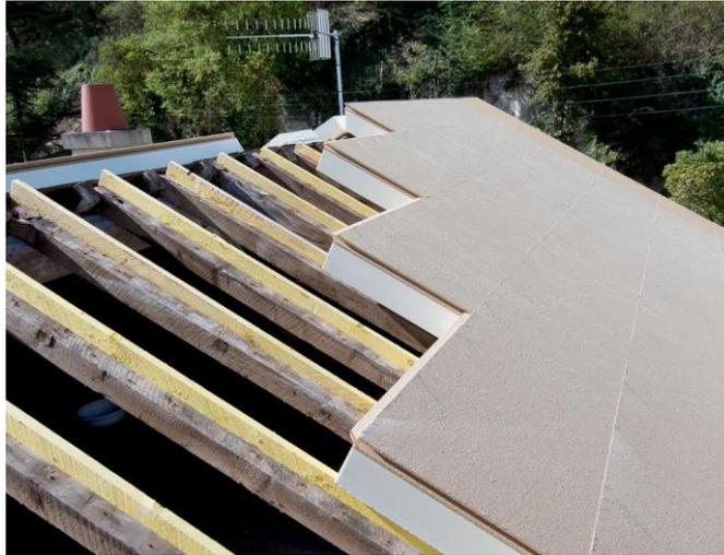
**Figure I-14 :** Principe de l'isolation du toit par l'extérieur. [19]
