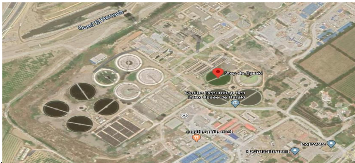
Figure I.6 : Localisation de la STEP de BARAKI
