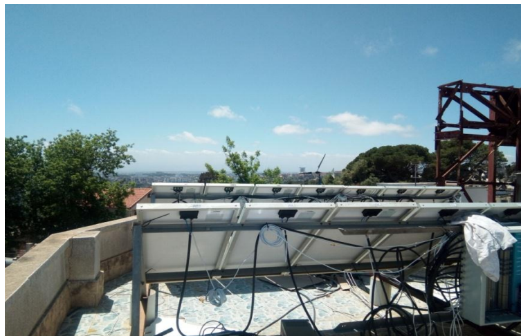
FIGURE IV-14 LE CABLAGE DU PREMIER CHAMP PV.
