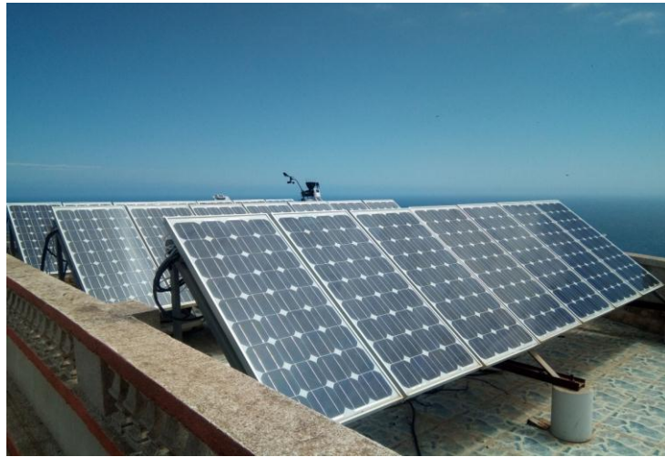
FIGURE IV-13 INSTALLATION DU PREMIER CHAMP PV.
