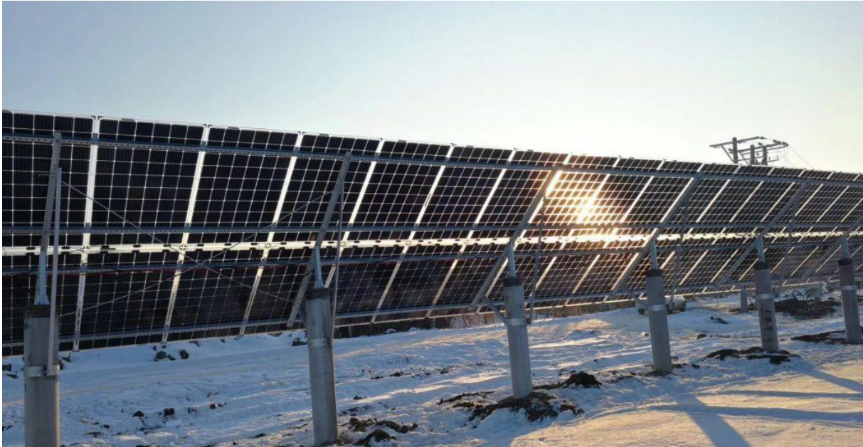
Figure 2.7 : Champ de panneaux bifaciaux suspendus [38].
