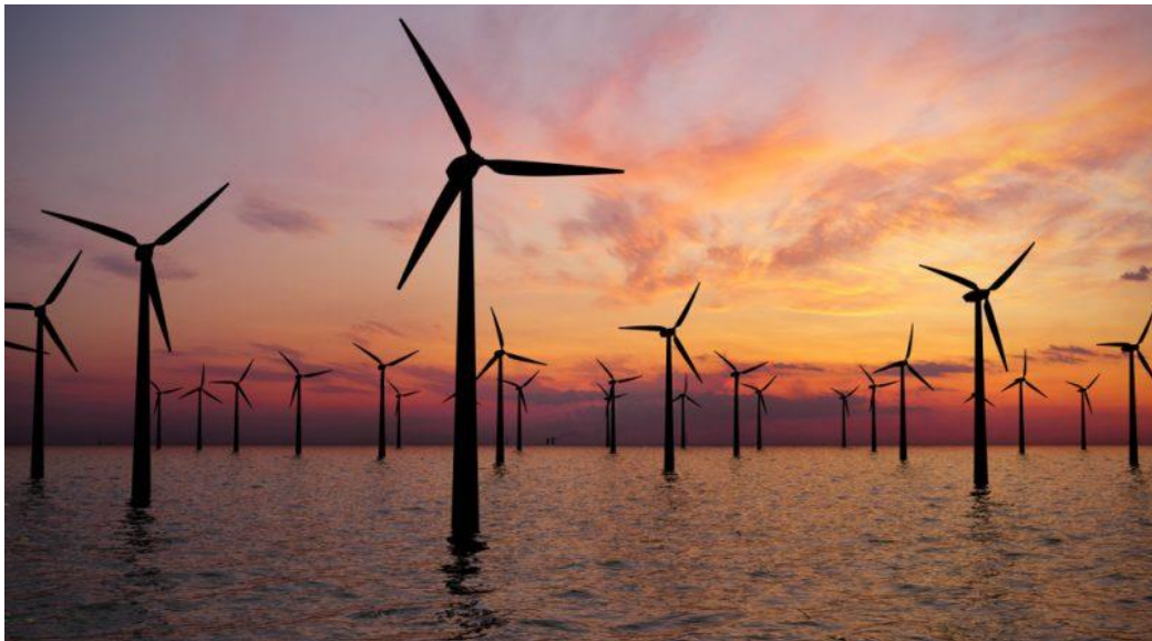
Figure 2.22 : Ferme éolienne off-shore [73].
