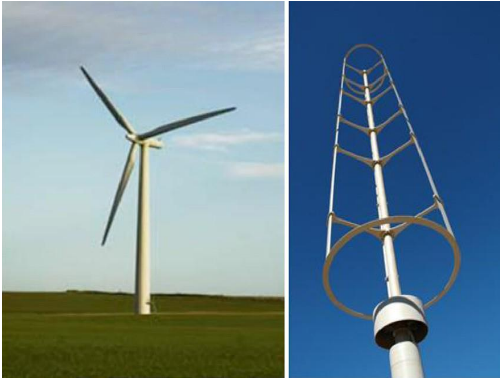
Figure 2.18 : Eoliennes à axe horizontal et vertical [53][54].
