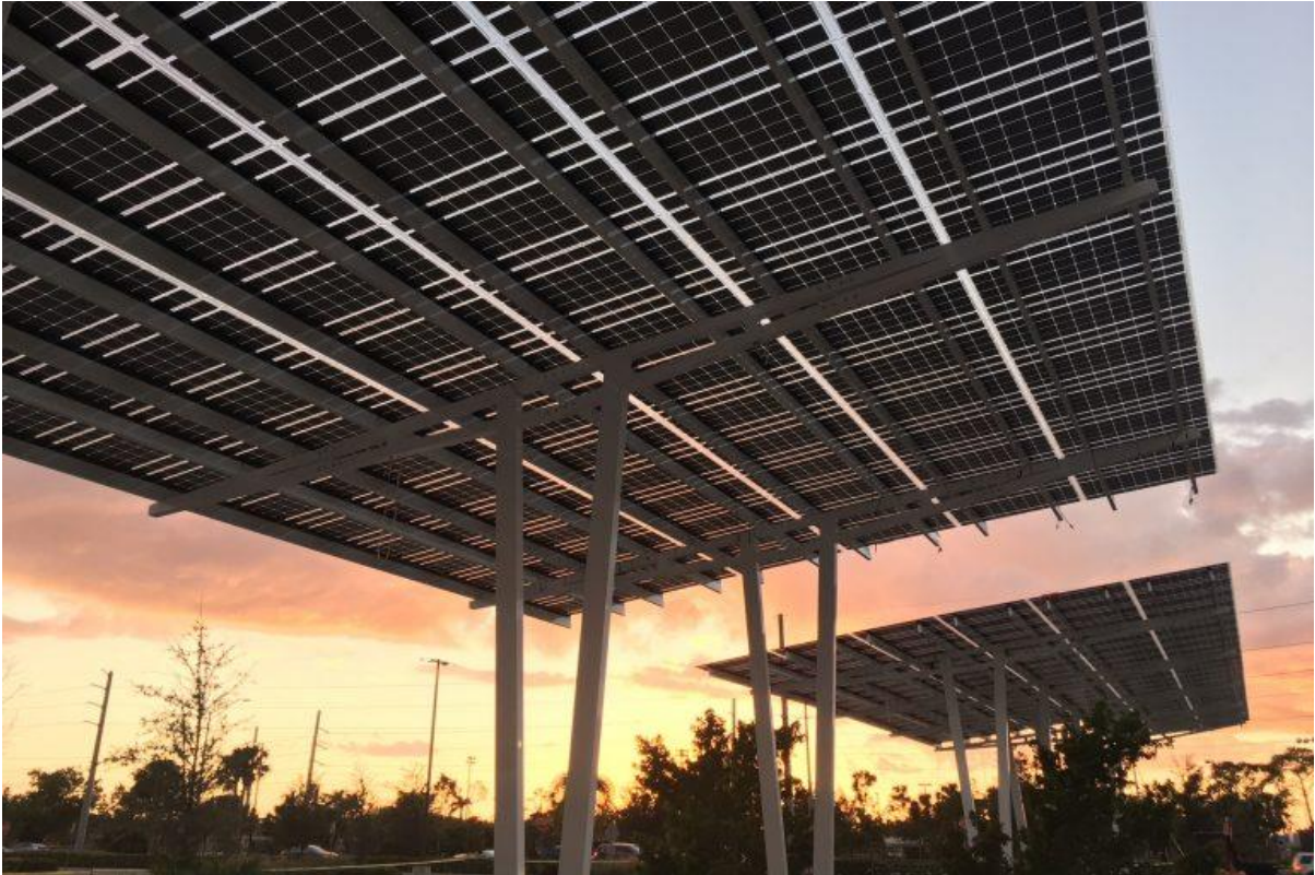
Figure 2.6 : Panneau solaire bifacial utilisé comme ombrière [34].
