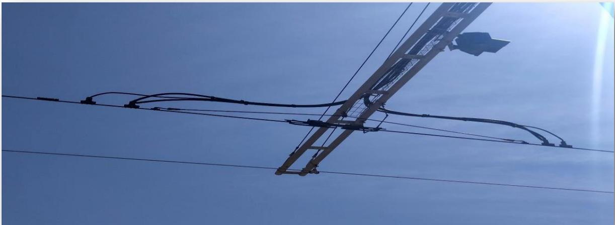
Figure I.4 : Point d'injection sur la **LAC** (**nourrice**)
