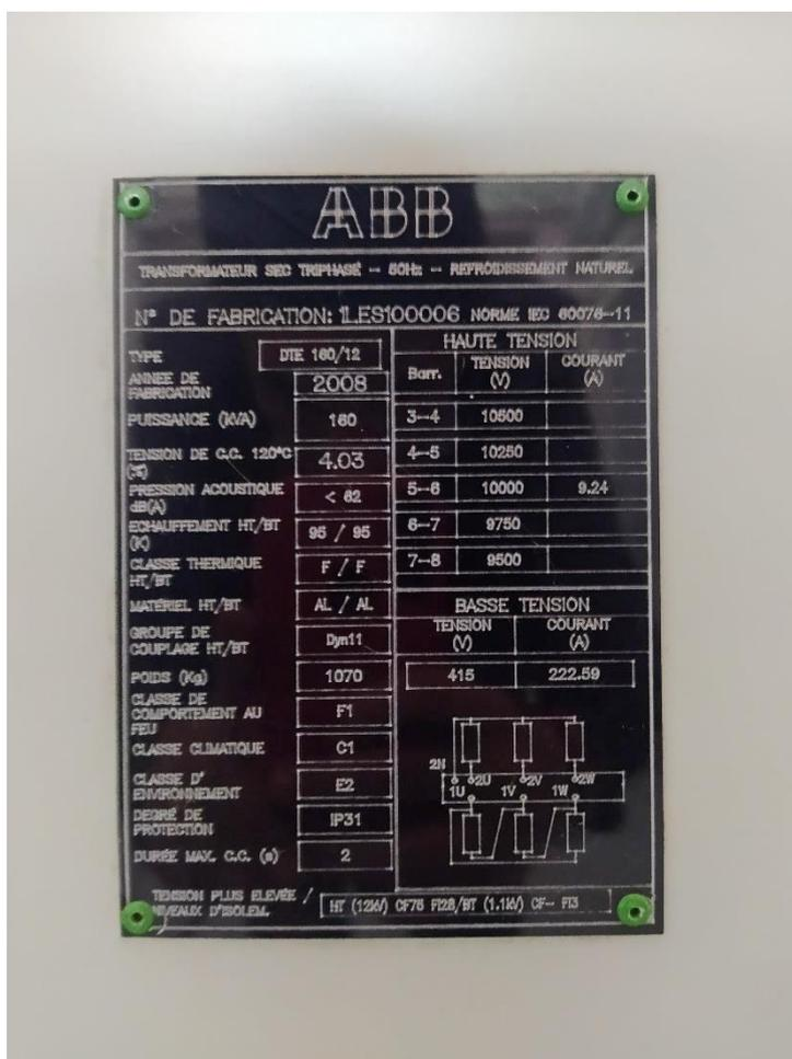
Figure A.4 : Plaque signalétique du transformateur des auxiliaires
