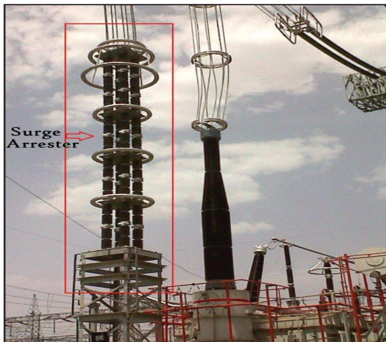
Figure II.16 : Parafoudre (en anglais Surge Arrester)
