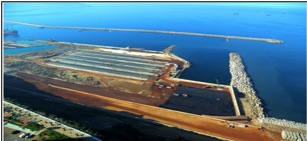
Figure 32 : Le terrassement du terminal
