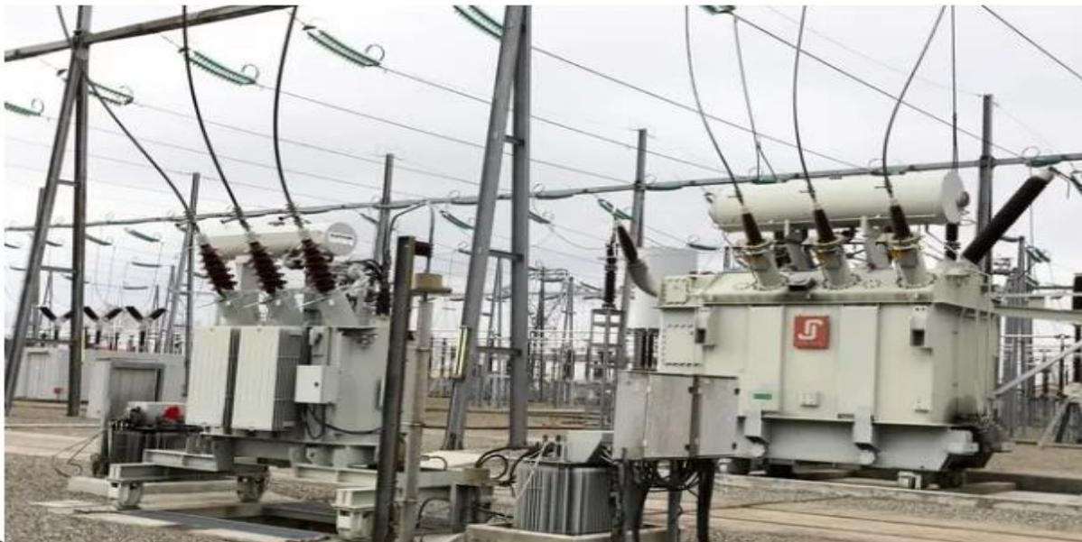
Figure 1.7: Jeu de barre et transformateur électrique haute tension
