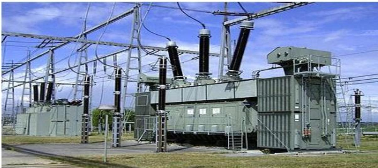
Figure 1.9:transformateur de puissance
