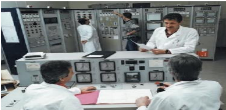
Figure 1.1 : Tableau de contrôle radiologique intégré au poste de conduite du réacteur CABRI du CEA Cadarache « Enjeu économique et de sécurité »
