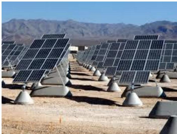
Figure I.2 : Installation avec traqueur solaire [5]
