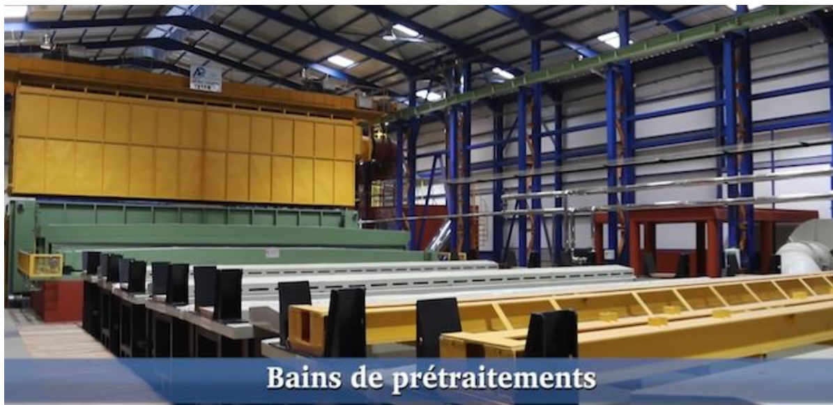
Fig.I.10 : Les bains des neuf étapes de galvanisation (prétraitements).
