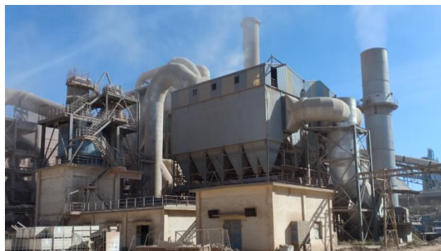
Figure I.3: Filtres à manches.
