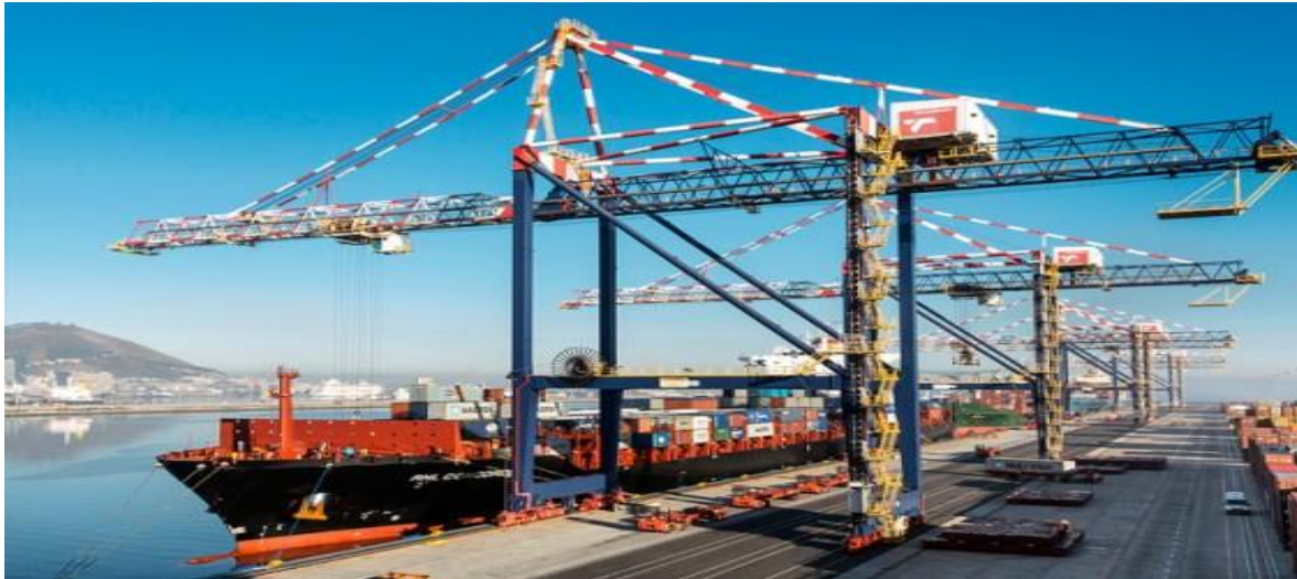
Figure 50 : portiques de quai de LIEBHERR.
