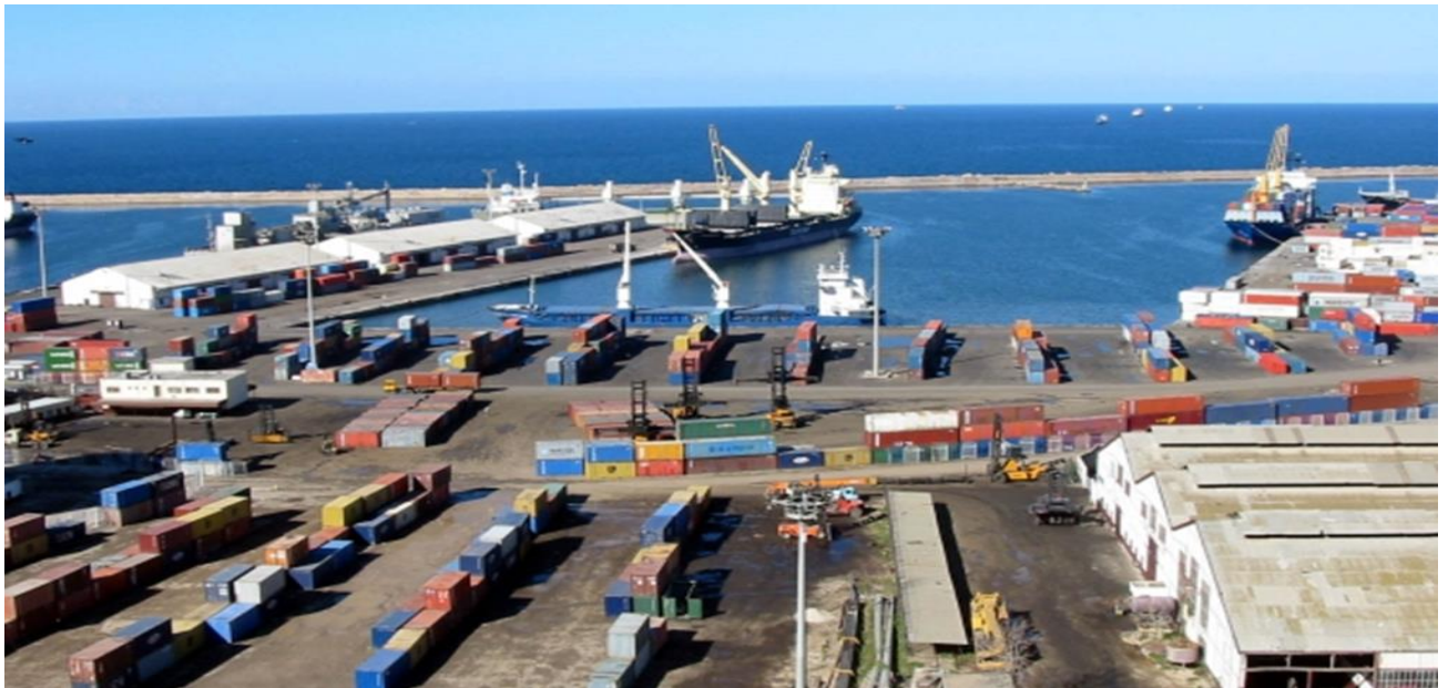
Figure 13 : terminal à conteneurs de l'EPO.
