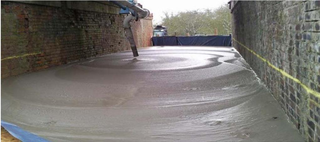
Figure 5.8 Représentation du béton cellulaire et sa mise en place
