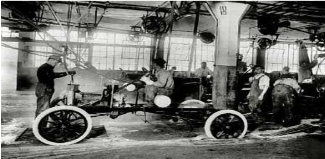
Figure I-4 L'arrivée de l'électricité.
