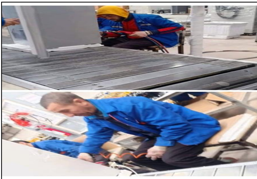
Figure 41 : les opérations de la phase 2(Chargement de gaz, soudure et kobra)
